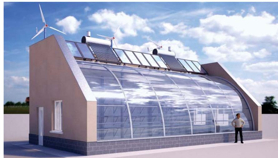
**Опытный единичный модуль теплицы с гибридной системой энергоснабжения**
